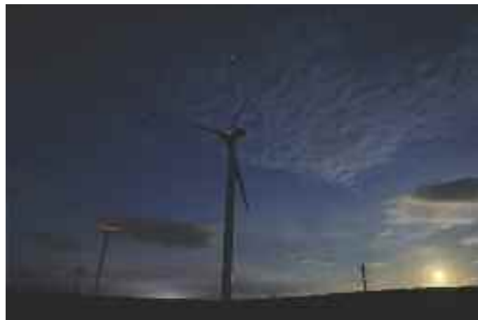
Vindparken på Havøygavlen. © Foto: Jarle Wæhler / Statens vegvesen
